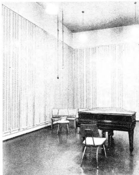
Studio mit wandelbarer Akustik im Funkhaus Köln. Durch Verstellen der Schlitzbreiten in den Wänden kann der Schall mehr oder weniger reflektiert oder verschluckt werden. (Aufnahme: Walter H. Schmitt).
